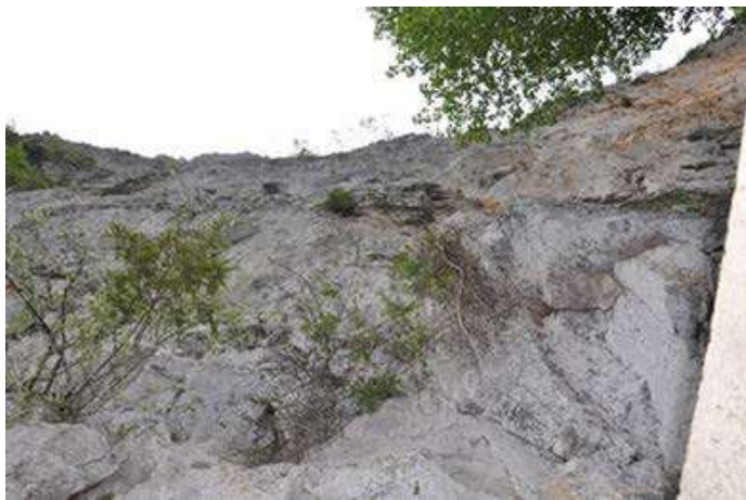
Photo de la paroi rocheuse surplombant le bâtiment de captage de l'Aygue Blanche.
