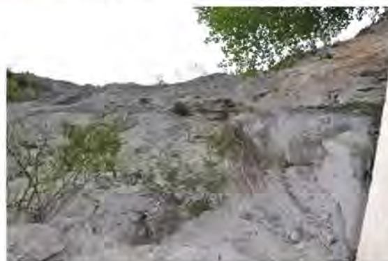
Photo 1 - Paroi rocheuse surplombant le bâtiment de captage de l'Aygue Blanche.
