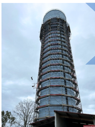
Travaux de réhabilitation du château d'eau de Viella
