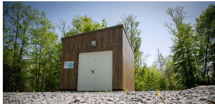
Photo 12 – Forage de Baudreix
