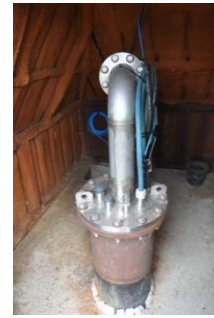
Photo 10 - Forage de Burosse-Mendousse
