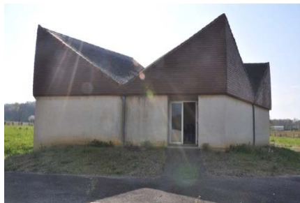
Photo 18 - Usine de Burosse-Mendousse
