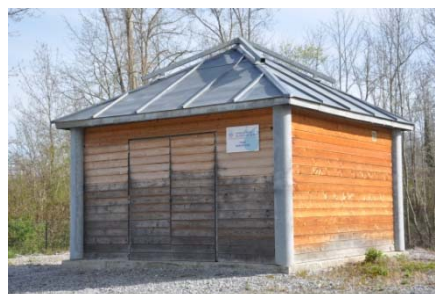
Photo 7 - Forage de Baudreix
