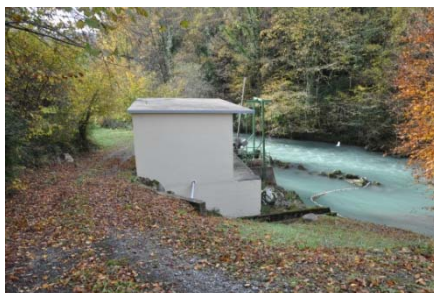
Photo 6 - Prise d'eau dans l'Ouzom
