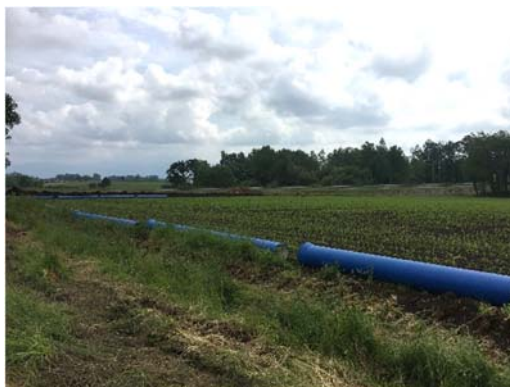
Photo 21 - Travaux de renouvellement liaison Luquet-Maucor
