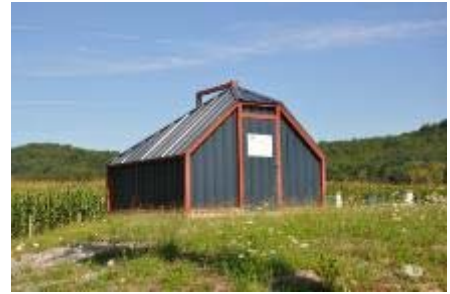
Photo 7 - Forage de Bordes F1
