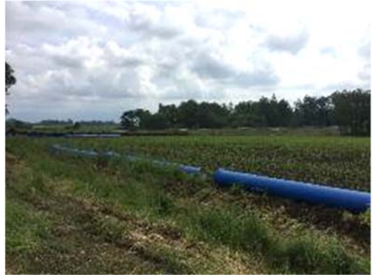
Photo 23 - Travaux de renouvellement liaison Luquet-Maucor
