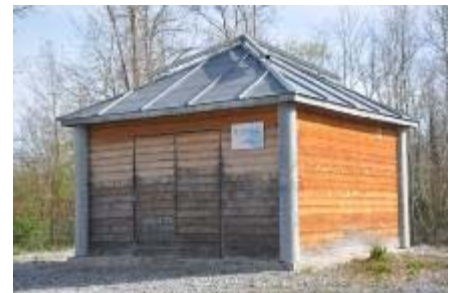
Photo 8 - Forage de Baudreix
