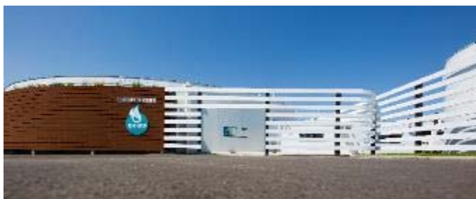
Photo 13 – Réservoir de Pontacq
