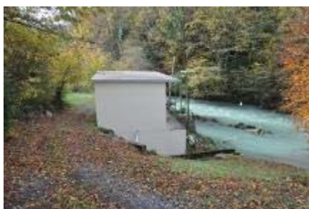
Photo 6 - Prise d'eau dans l'Ouzom
