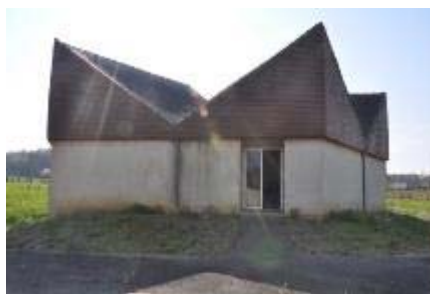
Photo 19 - Usine de Burosse-Mendousse
