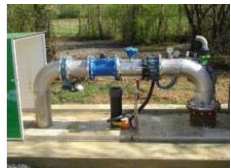
Photo 9 - Forage de Simacourbe
