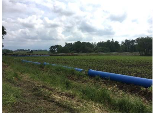
Photo 24 - Travaux de renouvellement liaison Luquet-Maucor
