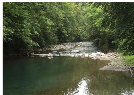
Photo 14 - Seuil sur l'Ouzom (août 2016)
