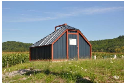
Photo 7 - Forage de Bordes F1
