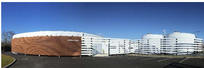
Photo 26 - Réservoir de Pontacq 5000 m 3
