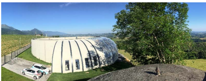
Photo 27 - Réservoir de Sarramayou 3000 m 3
