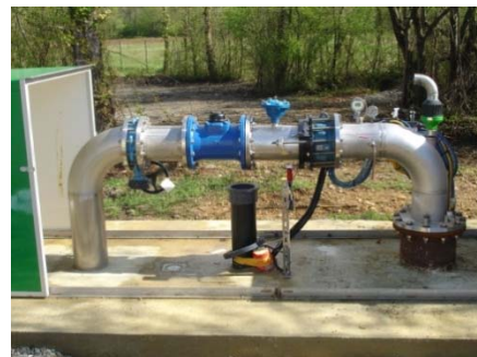
Photo 9 - Forage de Simacourbe
