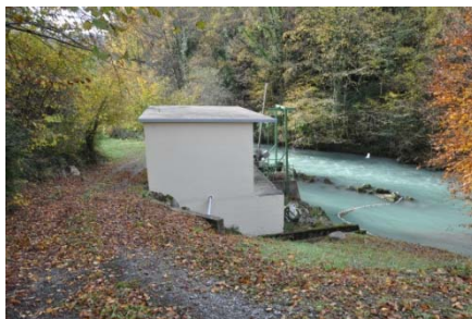
Photo 6 - Prise d'eau dans l'Ouzom
