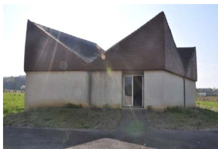
Photo 20 - Usine de Burosse-Mendousse
