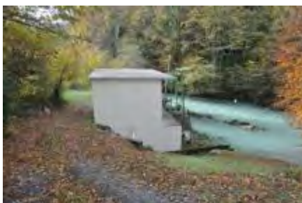
Photo 6 - Prise d'eau dans l'Ouzom
