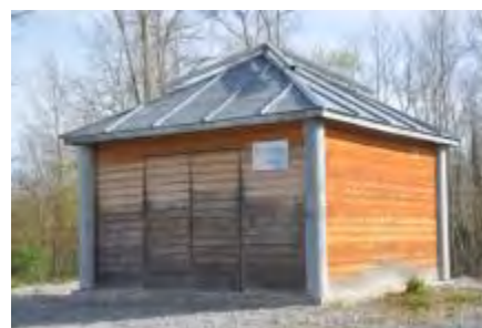
Photo 8 - Forage de Baudreix
