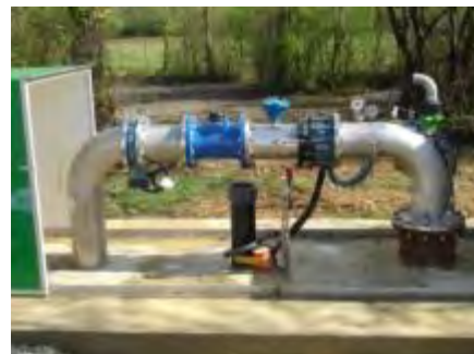
Photo 9 - Forage de Simacourbe
