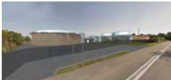
Photo 26 - Réservoir de Pontacq 5000 m 3
