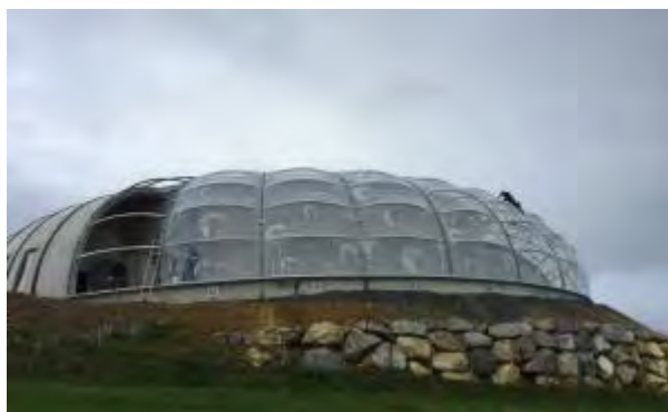
Photo 27 - Réservoir de Sarramayou 3000 m 3
