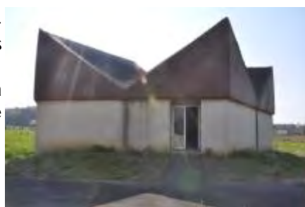
Photo 19 - Usine de Burosse-Mendousse
