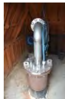
Photo 11 - Forage de Burosse-Mendousse
