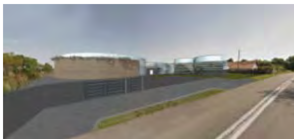
Photo 27 - Réservoir de Pontacq 5000 m 3
