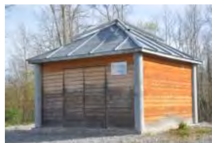
Photo 8 - Forage de Baudreix
