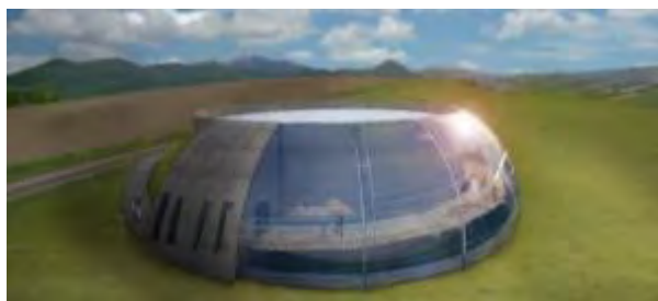
Photo 28 - Réservoir de Sarramayou 3000 m 3
