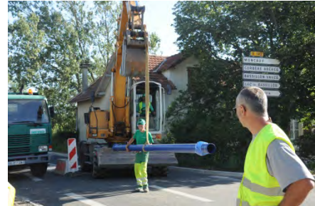
Photo 22 - Pose d'une canalisation sur la commune de Lembeye
