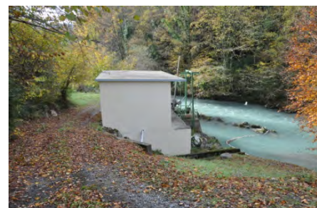
Photo 6 - Prise d'eau dans l'Ouzom
