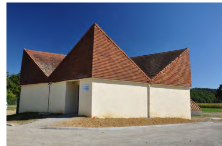
Photo 25 - Usine de Burosse-Mendousse
