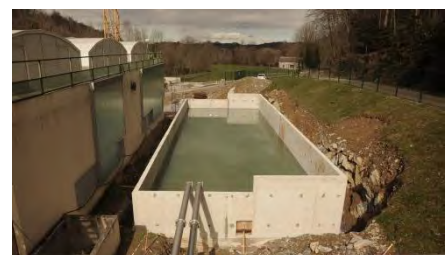
Photo 27 - Lagune de traitement des boues (usine d'Arthez-d'Asson)
