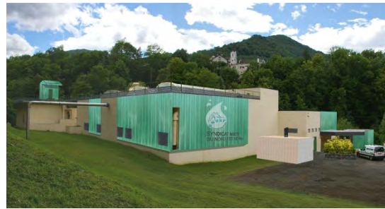
Photo 24 - Travaux de modernisation de l'usine d'Arthez-d'Asson
