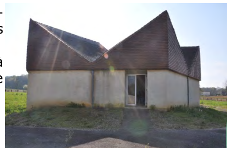
Photo 19 - Usine de Burosse-Mendousse
