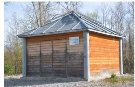
Photo 8 - Forage de Baudreix
