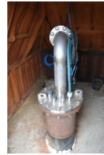
Photo 11 - Forage de Burosse-Mendousse
