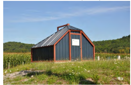
Photo 7 - Forage de Bordes F1
