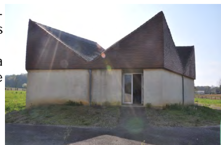
Photo 17 - Usine de Burosse-Mendousse
