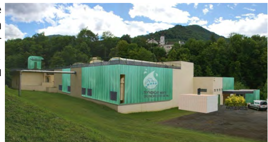
Photo 27 - Travaux de modernisation de l'usine d'Arthez-d'Asson
