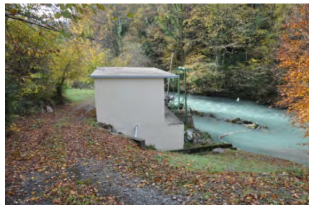
Photo 6 - Prise d'eau dans l'Ouzom
