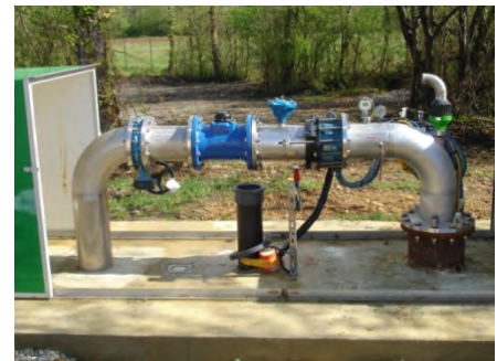
Photo 9 - Forage de Simacourbe
