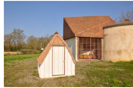
Photo 28 - Usine de Burosse-Mendousse
