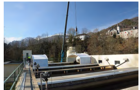
Photo 24 - Couverture des filtres à sable de l'usine d'Arthez-d'Asson
