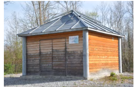
Photo 8 - Forage de Baudreix
